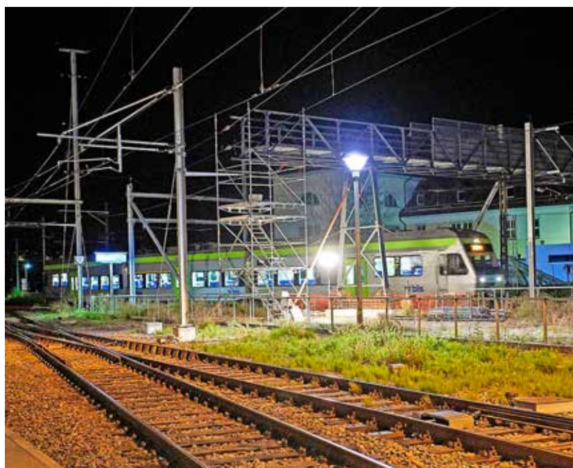
Um Zugsausfälle zu vermeiden, fanden die Arbeiten teils in der Nacht statt.
