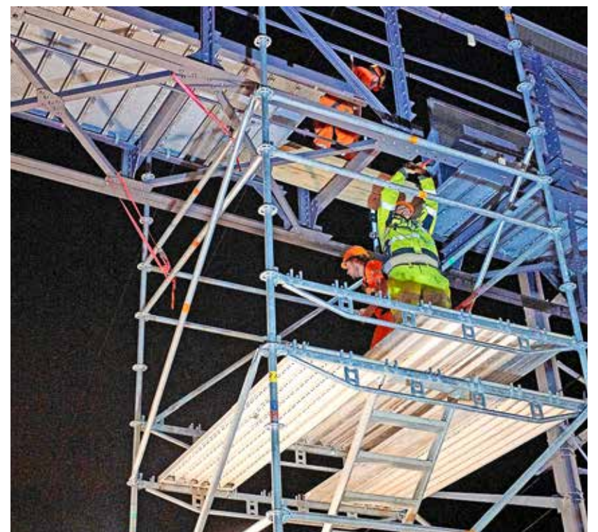
Mit 100 Schrauben wurden die beiden Teilstücke des Stahlfachwerks verbunden.
