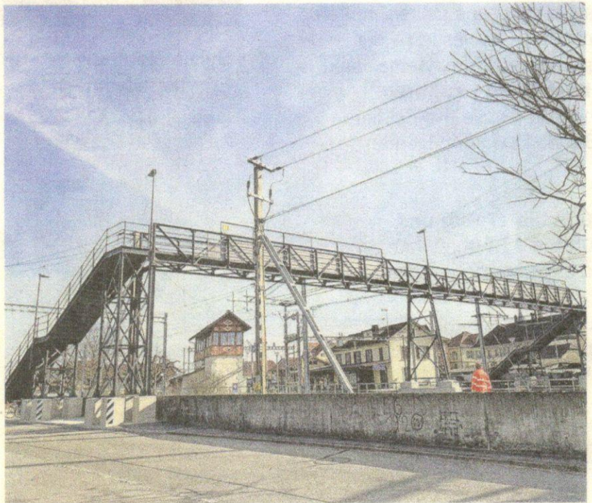
Das Wahrzeichen von Kerzers ist wieder begehbar.
