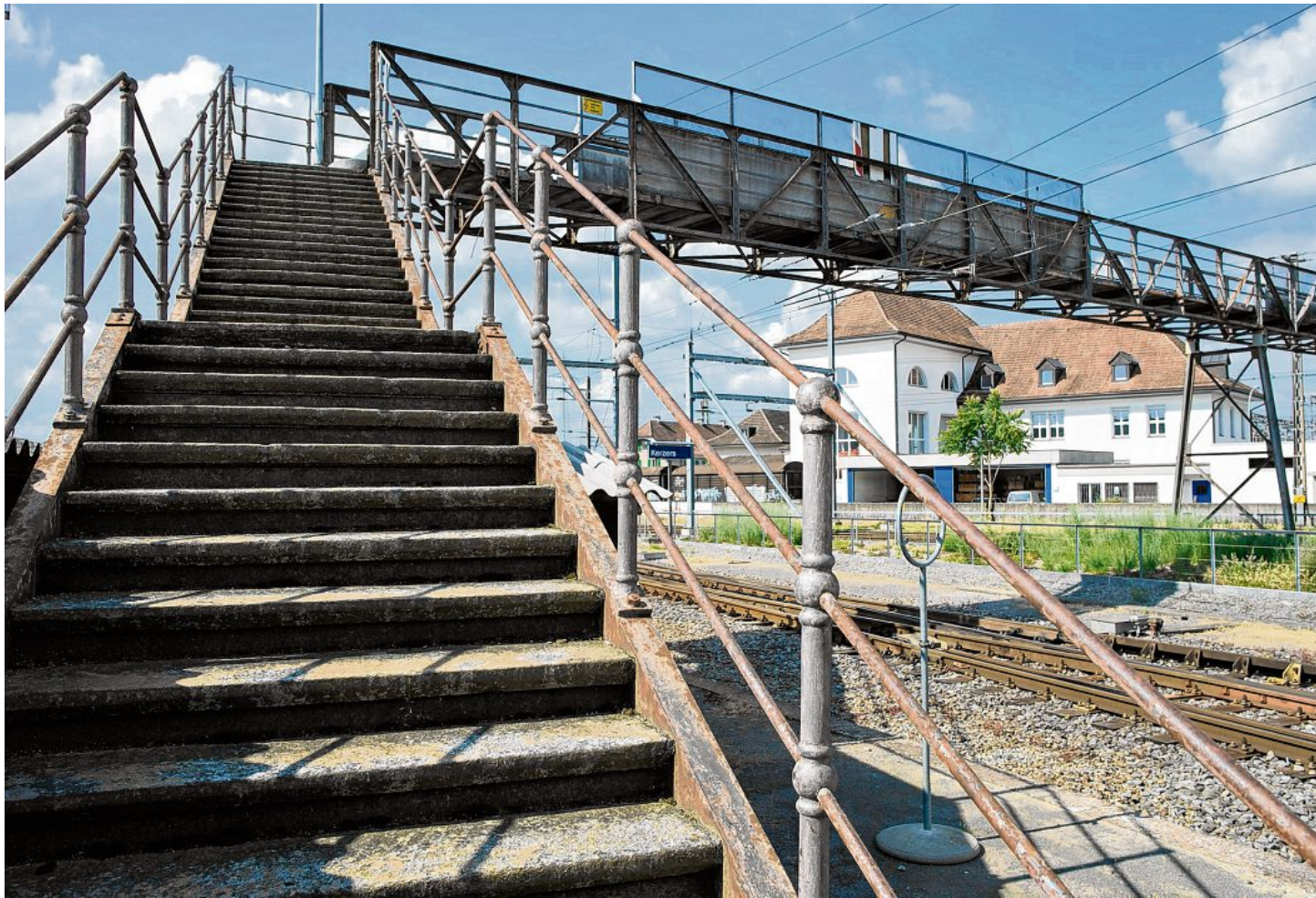
Die Passerelle beim Bahnhof Kerzers wird von den SBB für eine halbe Million Franken saniert.
