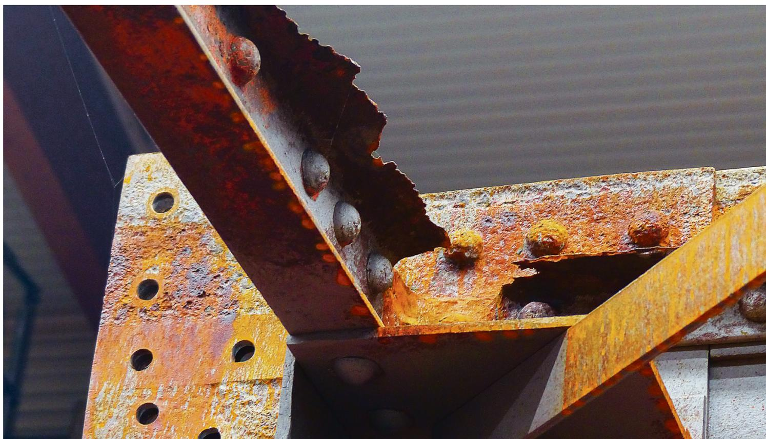
Die Korrosion hat der Passerelle zugesetzt, der Rostfrass ist gut sichtbar.
