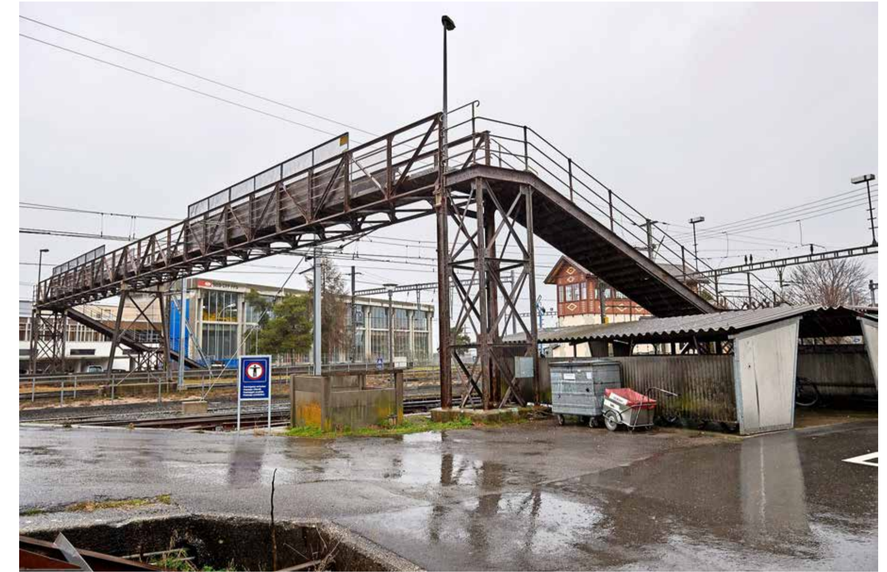
Die Passerelle bildet mit dem Stellwerk (hinter der Treppe) ein historisches Ensemble. Doch die Veloplätze mit Wellblech stören, findet der Verein Passerelle Kerzers.
